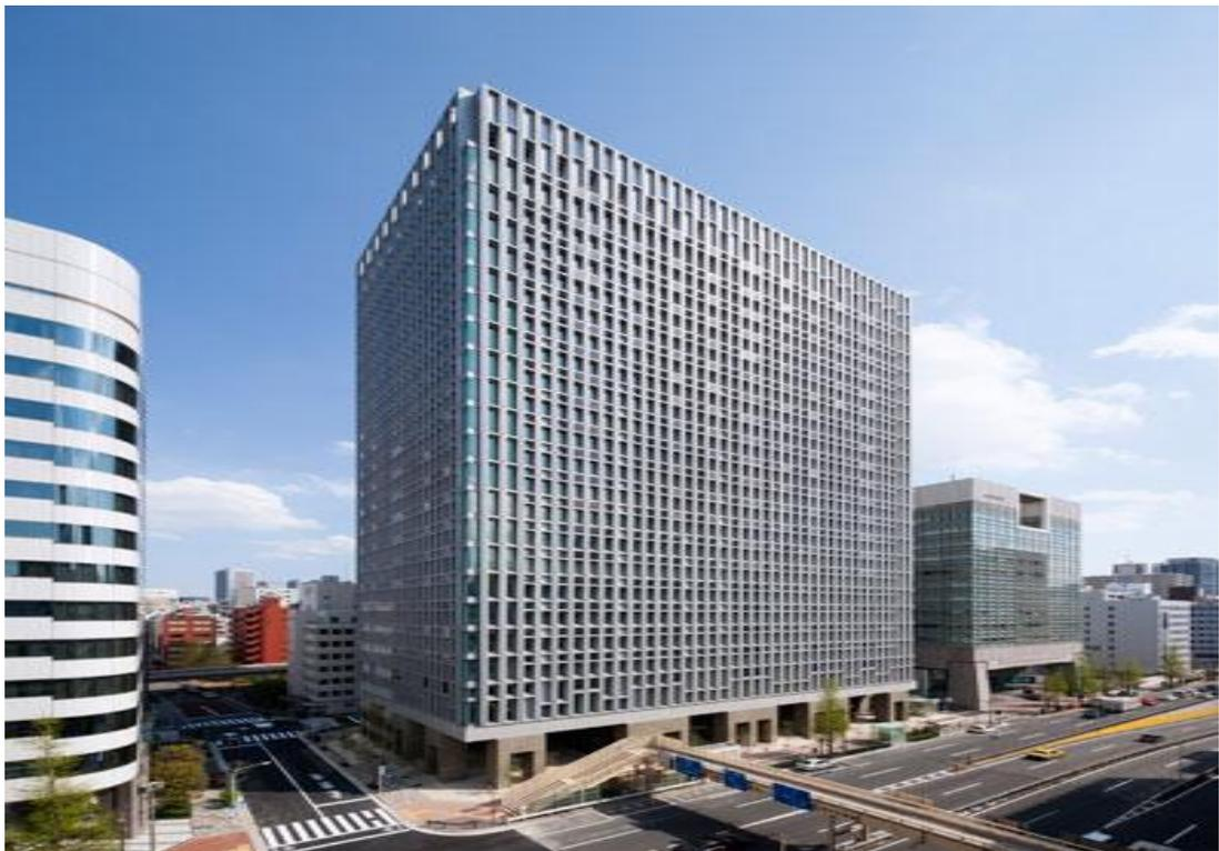
清水建設本社ビル 地下3階・地上22階+塔屋1階 RC造 51,365 m<sup>2</sup>
